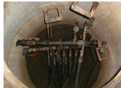
Abb.10 Nicht fachgerecht erstellter Soleverteiler
