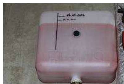
Abb.12 Offenes Sole-Ausdehnungsgefäß
