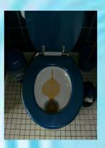
Eisen- und / oder Manganoxide führen zu Ablagerungen und Verfärbungen in den sanitären Einrichtungen.
